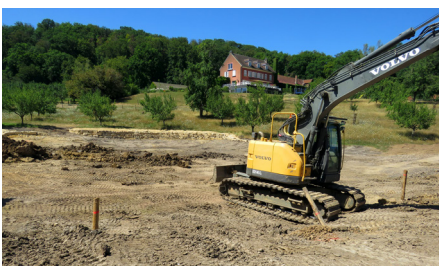
▲ Bagger-Aarbechten un den neien Weieren um Kléngelbuer.
