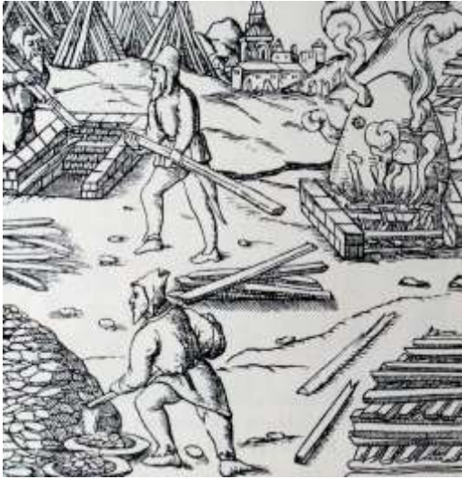
Bau von Röstschütten und Grillöfen
