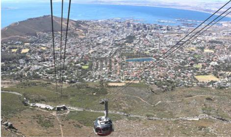
hoch. In den ROTAIR-Kabinen, die sich während der Fahrt um sich selbst drehen, haben 65 Personen Platz. Die beiden Kabinen fahren auf zwei Trasseilen und werden von einem Zugseil bewegt. Auf der 1200 Meter langen Strecke gibt es keine Stützen. Die Seilbahn kann über 800 Personen pro Stunde befördern. Die Aussichten von oben sind unbeschreiblich, einfach „mega“. Danach führen wir auch noch zum Signal Hill,
