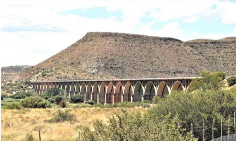
1901 eröffnete lange Bogenbrücke aus Sandstein ist eine sogenannte Kombi-Brücke (für Strasse&Eisenbahn) und mit ihren 1,2 km die längste Brücke dieser Art über den längsten Fluss (2.160km) in Südafrika. Nach einem kurzen Fotostopp ging es gleich weiter zum 3. Superlativ, dem
