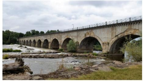
queren. Vor der Brücke befindet sich eine große Schleuse, auf der die Boote des Canals 9 Meter nach oben bzw. nach unten geschleust werden. Mit 18 Bögen, 16 Metern Breite und 343 Metern Länge (Schleuse inbegriffen 470m) ist dies eine der längsten Kanalbrücken in Frankreich und ein äußerst beeindruckendes Bauwerk aus dem frühen 19. Jahrhundert.
