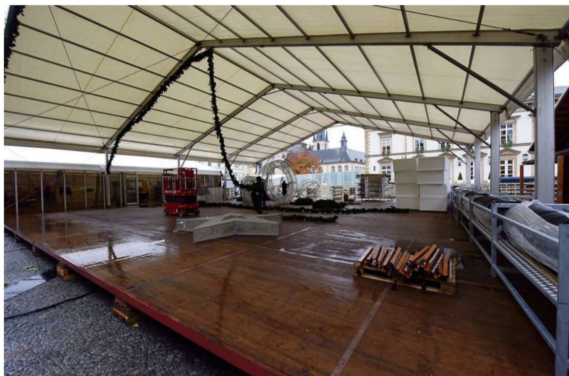
Noch wird eifrig gehämmert und gezimmert, damit die Eisbahn „Knuedler on Ice“ am 22. November betriebsfertig ist
