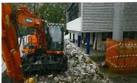
Hier entsteht der neue Bürokomplex mitsamt Dachterrasse
